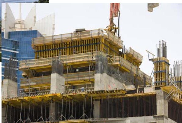
Penjajuća oplata tornja
