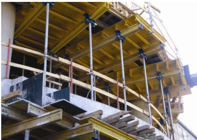
Dio oplatnih stolova kojima su se izvodile stropne ploče
